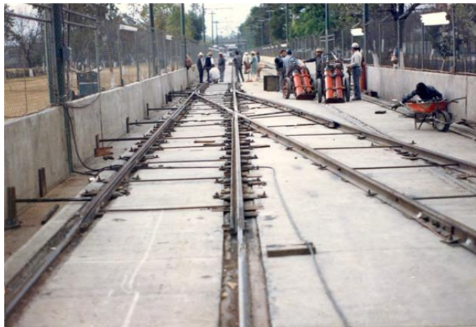
Construcción de la Superestructura de Vía antes de ahogarla en Concreto
