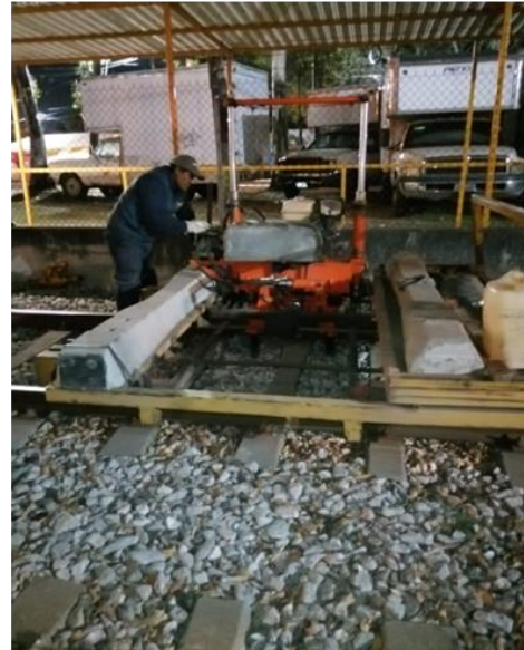
Cambio de Durmientes Dañados
