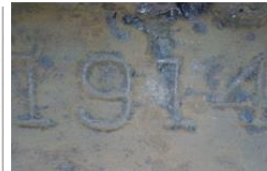
Año de Fabricación Riel de 80 Lbs./Y
